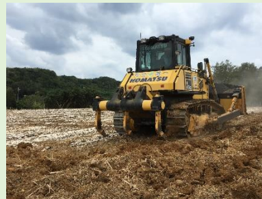
土壌改良:リッパーによる心土破碎
